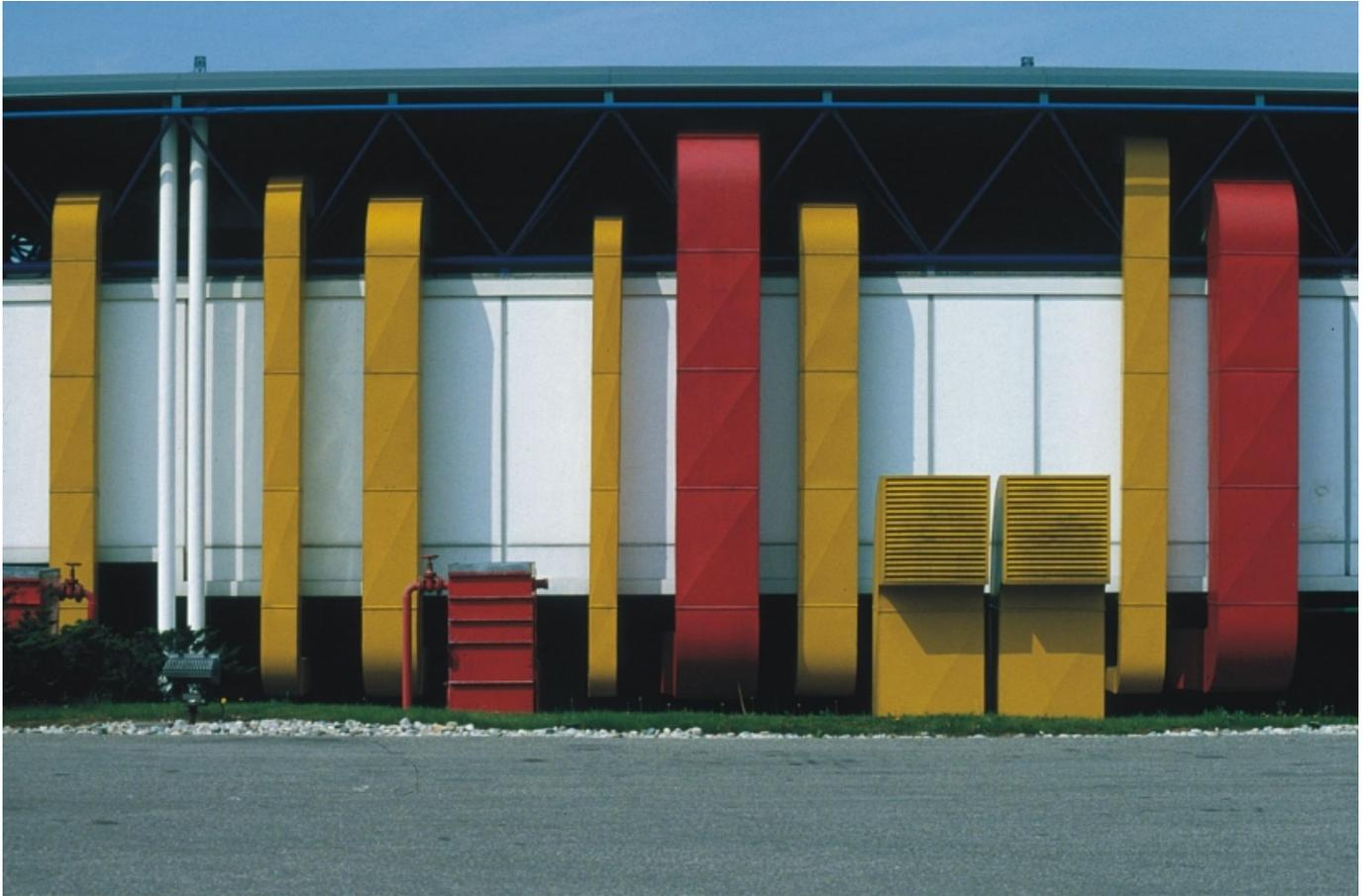
Il piccolo edificio viene progettato e costruito negli stessi anni del cantiere del Centre Pompidou (1971-77), di cui costituisce una prova generale in piccola scala. Con il grande museo parigino la sede degli uffici della B&B Italia a Novedrate, vicino Como, condivide la struttura in pezzi prefabbricati; la pianta libera; l'uso espressivo e ludico del colore; la posizione esterna dei condotti impiantistici, che avvolgono l'edificio come un secondo involucro, intersecando la struttura.
